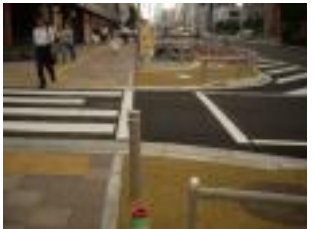
カーブが急な巻き込み部
